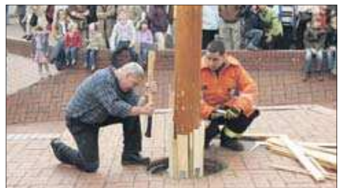
Dirk Herbst (links) und Patrick Heine befestigen mithilfe von Keilen den Maibaum in der Bodenhülse. Kannegießer (2)
